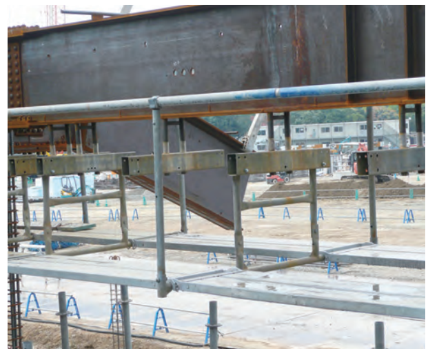
型枠組立後の状態
