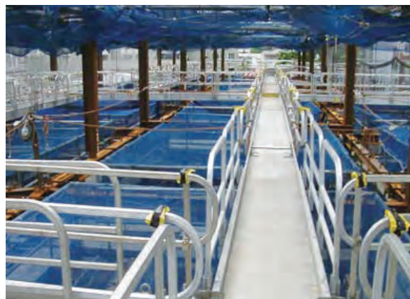
躯体工事（鉄骨梁上）に使用中のフライングブリッジ
