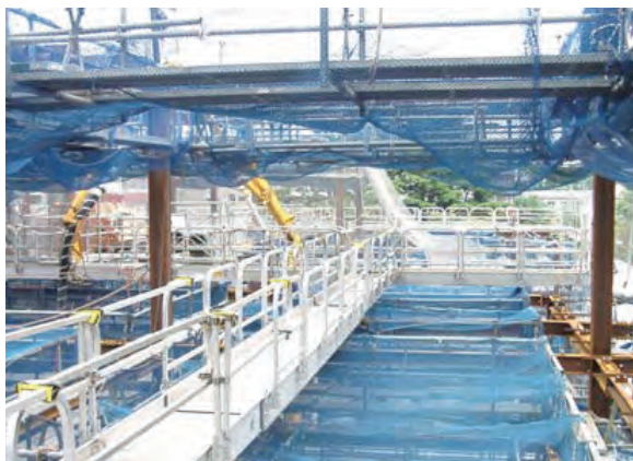
躯体工事（鉄骨梁上）に使用中のフライングブリッジ
