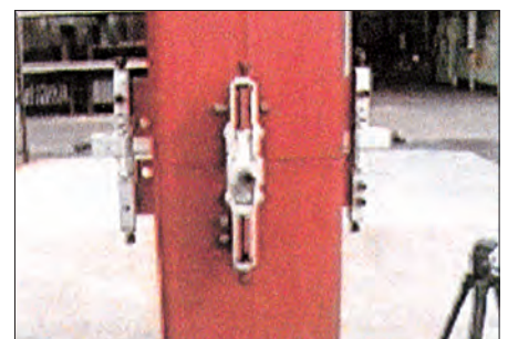
建て入れ完了
