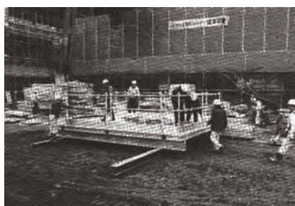
支柱及び手摺り、 巾木のセット
